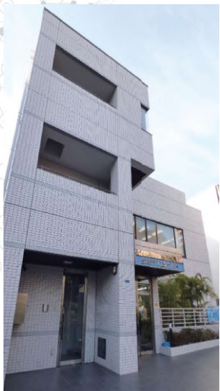
会社近影(日本硝子工業センタービル)
